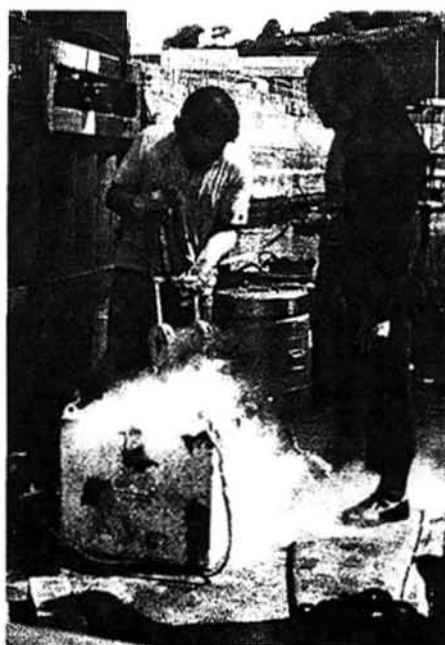
Abb. 1. Ein Rohrverbindungselement wird zur Montage aus dem Kältebad herausgenommen (Flüssigstickstoff).
